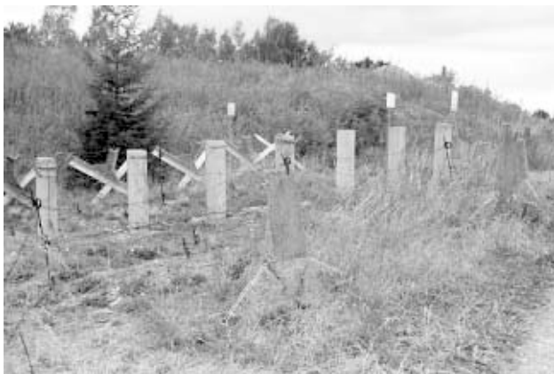
● Kozły zapór przeciwczołgowych i zapory przeciwpiechotne z drutu kolczastego. Zielony wzgórek za zaporami kryje w sobie zamaskowany blok artyleryjski „Zeleny”
