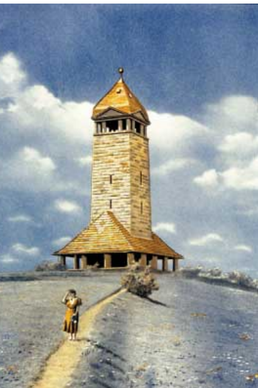
● 1. Wieża widokowa na Górze Świętej Anny przed przebudową na przekaźnik tv
