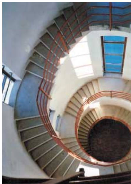
● 4. Schody w wieży widokowej na Suchym vrchu
