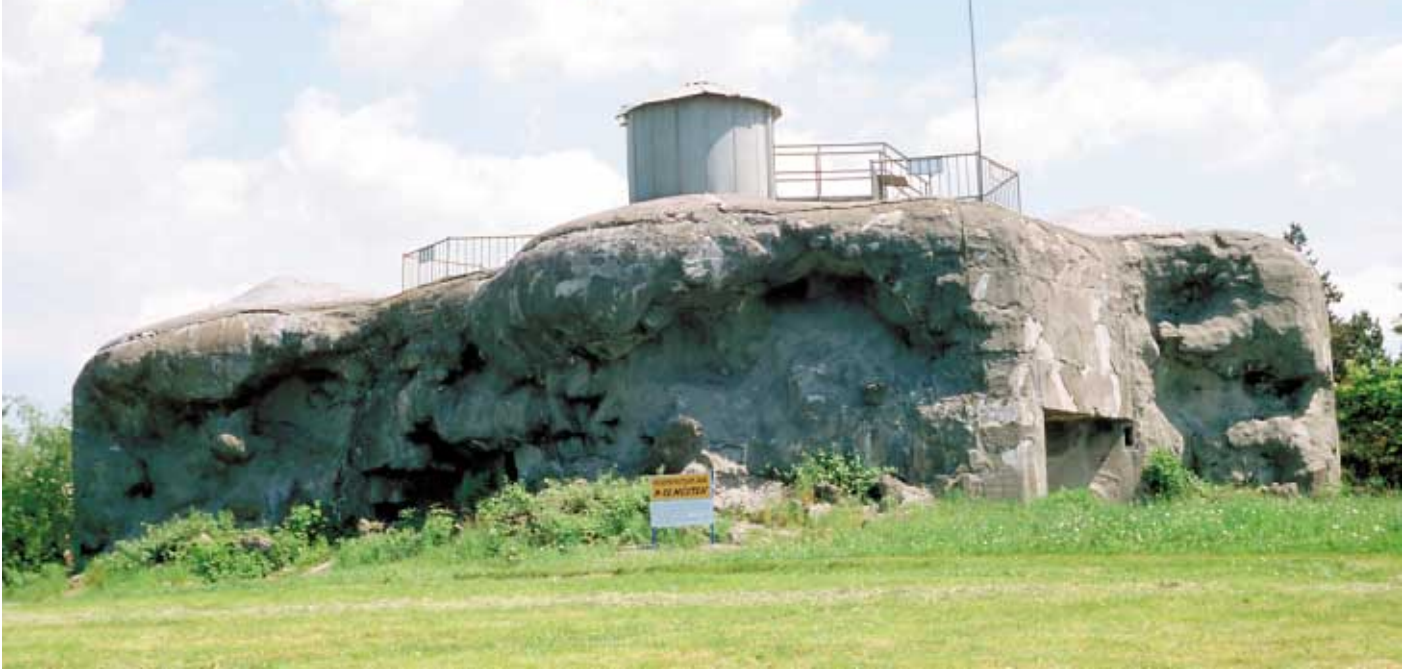
● Schron dowództwa „Mústek” (S 72). Od frontu widać uszkodzenia po niemieckich próbach z nową amunicją
