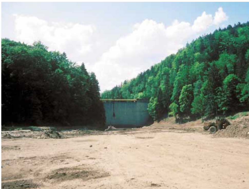
● Widok na osady dna suchego zbiornika i zaporę wodną w trakcie prac w 1998 r.
